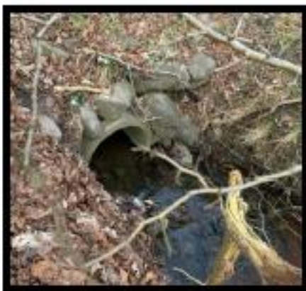
Rør under adgangsbroen til Malergården
