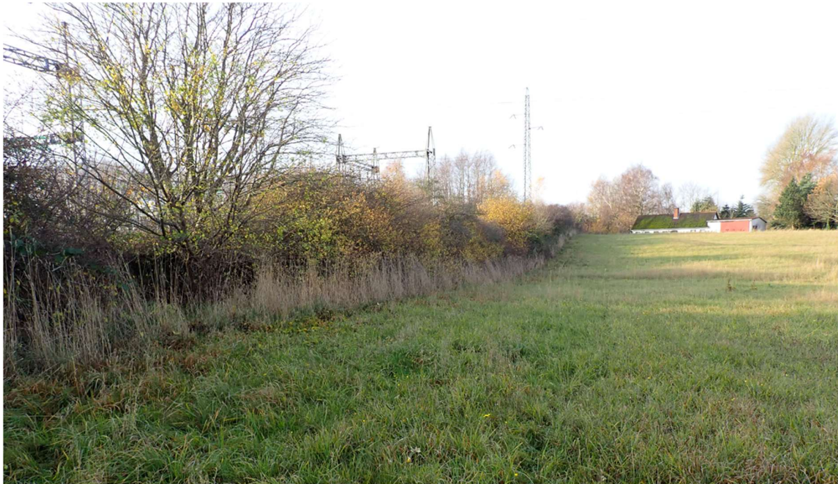
Foto 1: Diget ud for transformatorstationen
