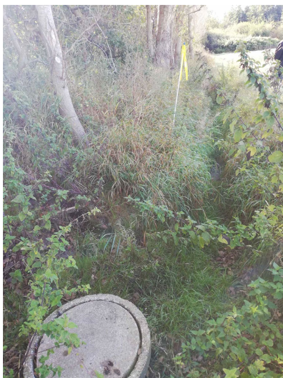
Figur 1 – Brønden hvor fra den nye grøft starter.
