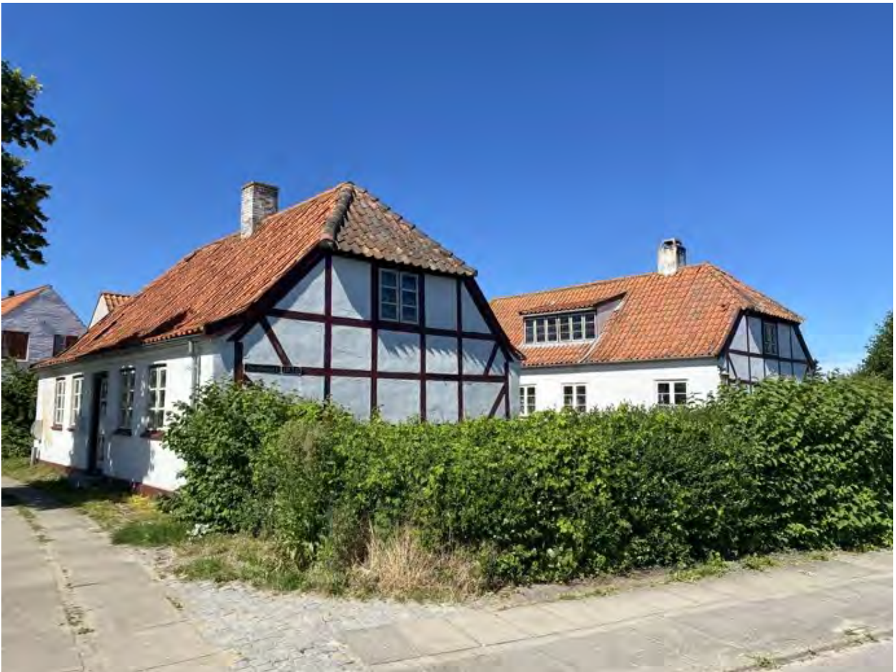
Bindingsværksgård i krydset ved Lindealle, Altavej, Østerlyngvej og den kommende vejadgang til planområdet.
