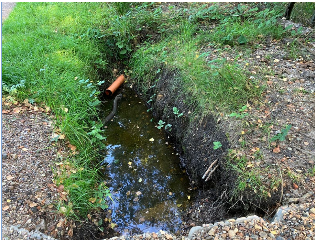
Figur 2 - Grøften ved Pilevænget 1, hvor røret løber ud i.
