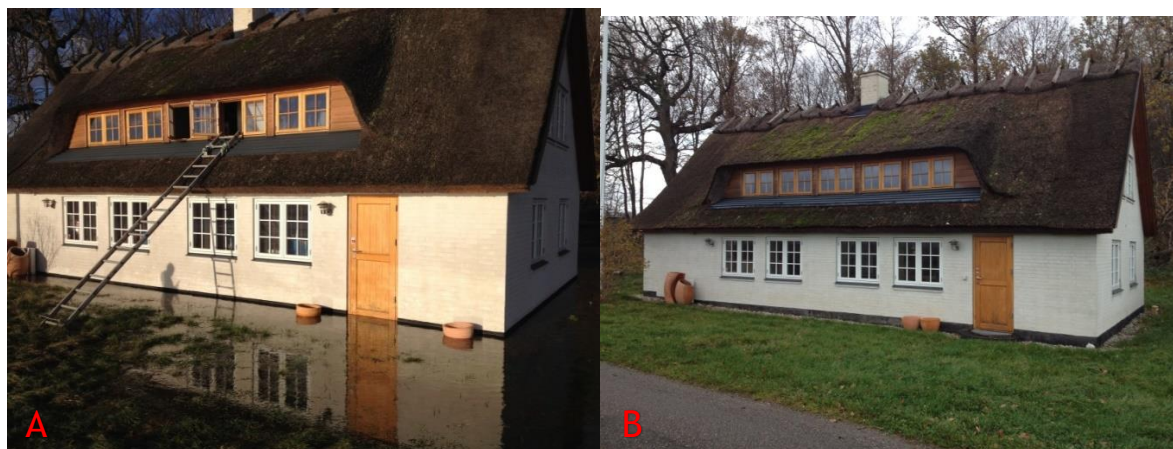
Foto A viser ejendommen under stormen Bodil i 2013 før maksimal vandstand var nået. Foto B viser ejendommen under normale forhold
