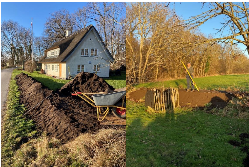
Foto af etablering af jorddige forud stormen 'Malik' i marts 2022
