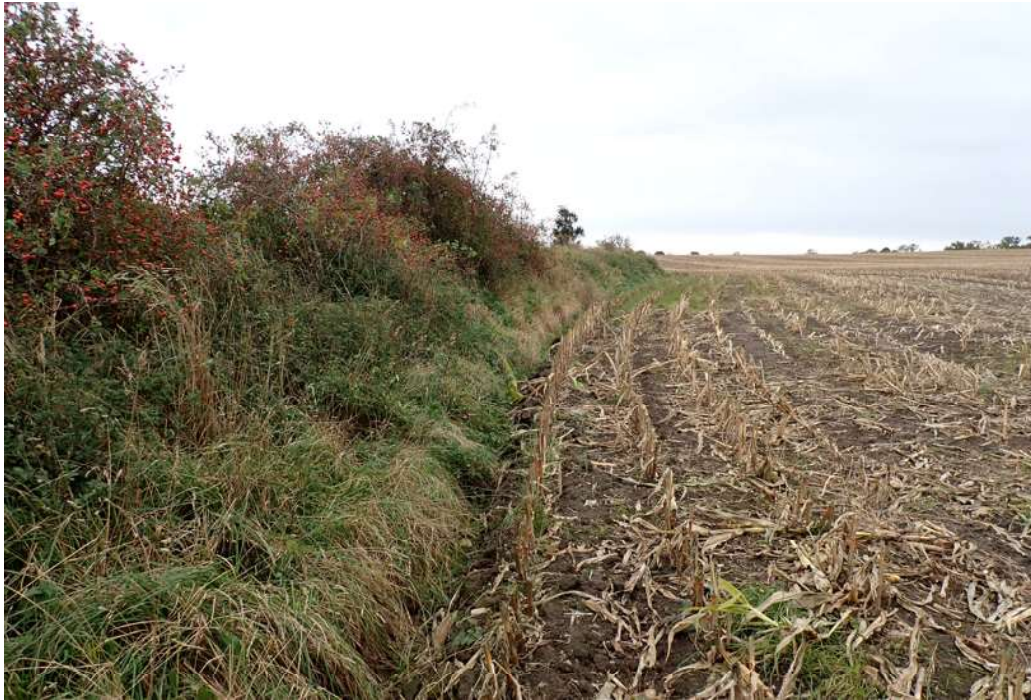
Foto 1: Diget set ved stedet for ønsket digegennembrud i retning mod Oddenvej.
