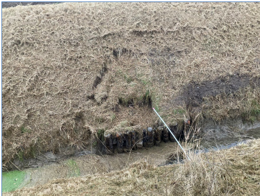
Figur 1 – Projektstrækning, hvor brinken skrider ned overfor regnvandsudløbet.
