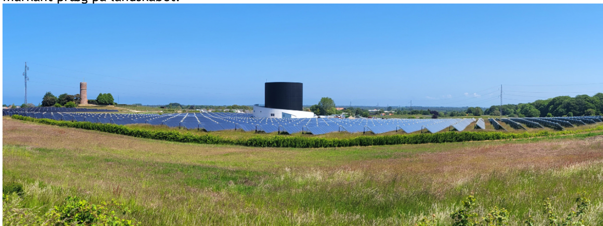
Figur 1: Eksisterende solpaneler og akkumuleringsstank set fra Odsherredvej.
