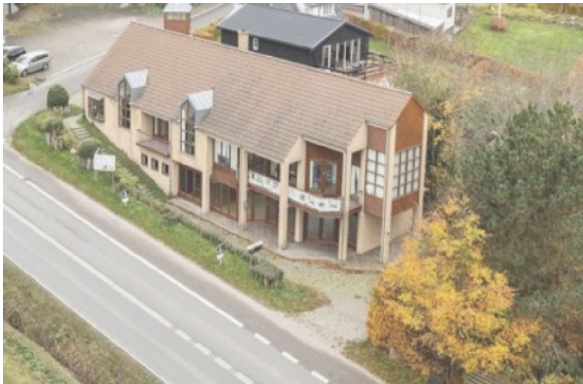
Figur 1 Foto af aktuell bygning.
