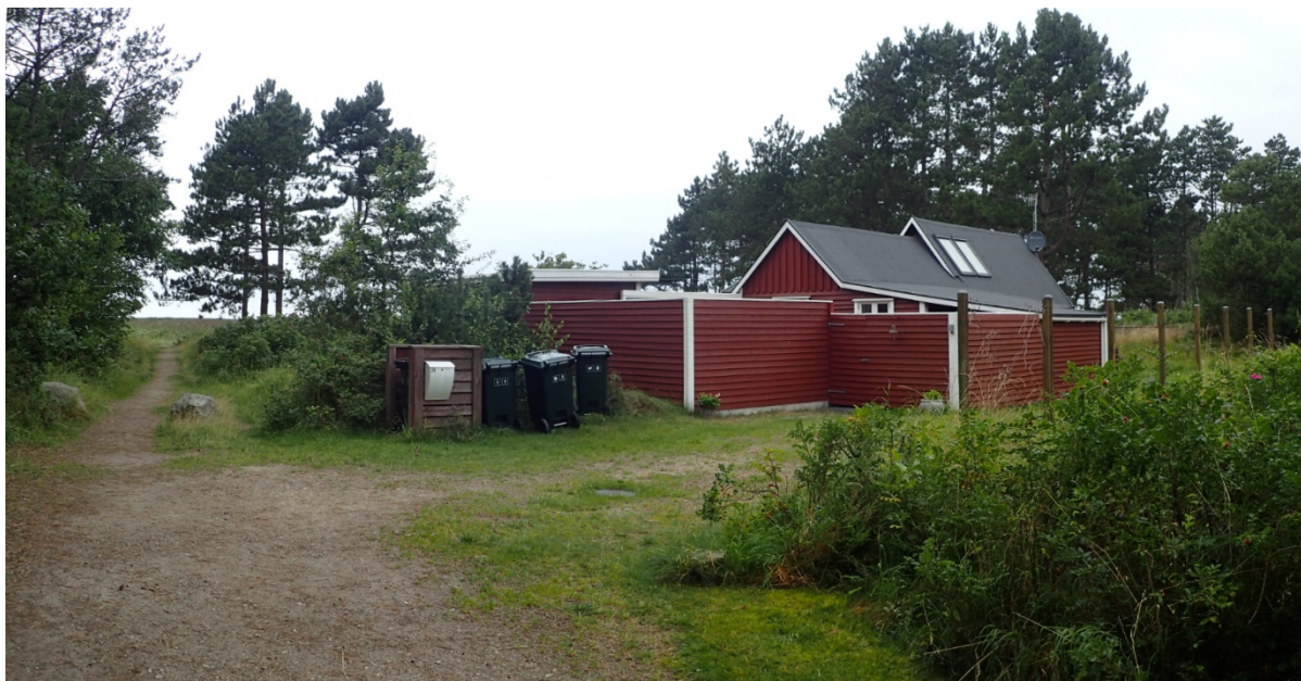
Figur 9. Panorama af bygningerne på Strandgårdsvej 24 set fra landsiden (sydøst).
