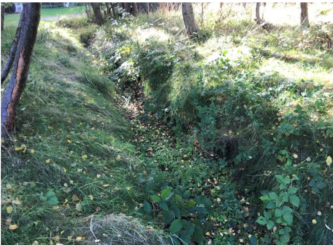
Figur 2. Grøften på Gudmindrup Skovkrog 7, som ønskes rørlagt.
