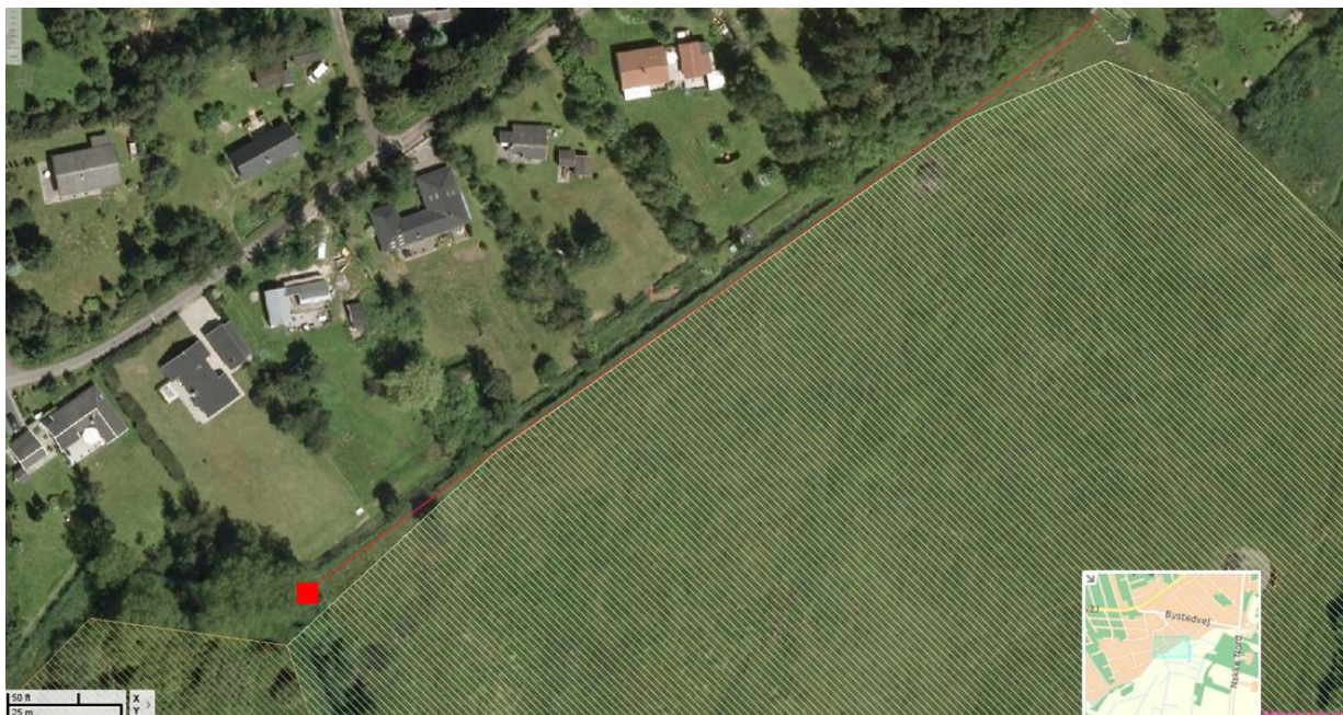
Figur 6-14. Engen ved kanalen, hvor der ønskes opgraderet et kørespor til vedligehold af den nye pumpestation. Rød streg indikerer sporet, der ønskes opgraderet, den røde firkant viser placeringen af den nye pumpestation. Skraveret grøn er § 3-eng og skraveret brun er § 3-mose.
