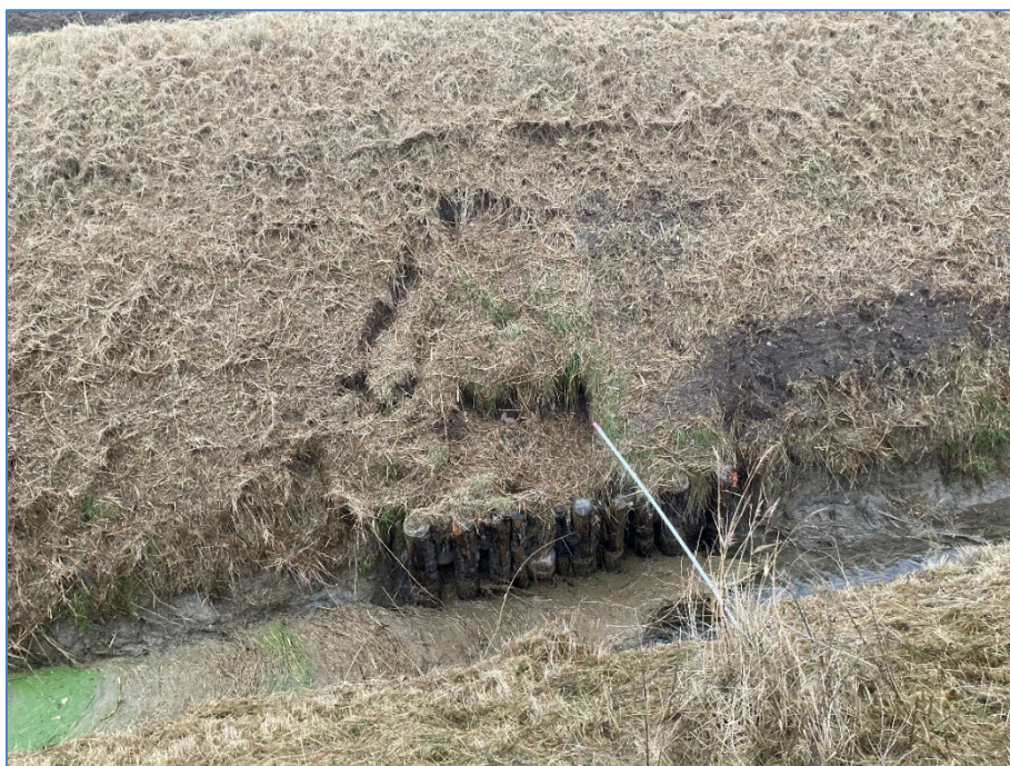
Figur 1 - Projektstrækning, hvor brinken skrider ned overfor regnvandsudløbet.
