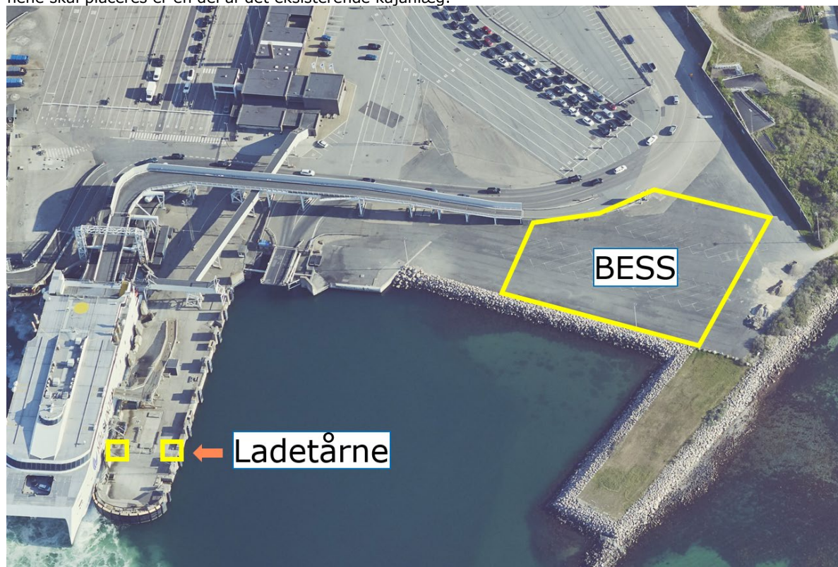
Figur 1-6: Skråfoto fra december 2023 med gul markering af arealet for det kommende BESS-anlæg (eksisterende asfalteret parkeringsplads) samt ladetårne på kajarealet.
