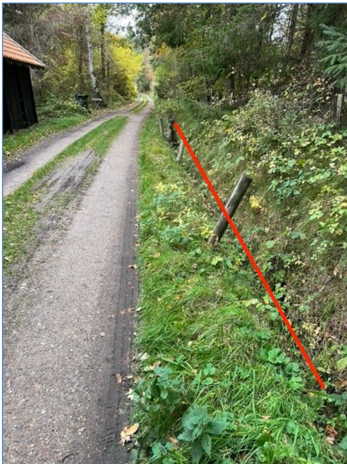
Figur 1 - Billede fra ansøgningen, som viser grøften ved Møllerens Vænge 25/Lærkevænget 30
