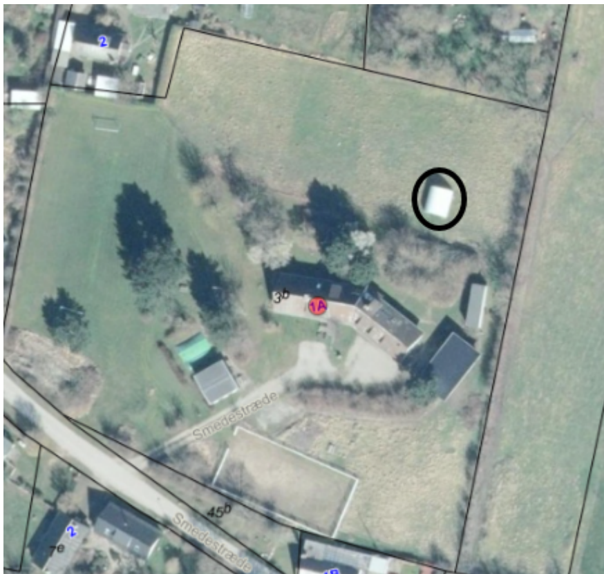
Figur 1 Luftfoto (fra 2024) af ejendommen. Sort cirkel omkring det aktuelle læskur
