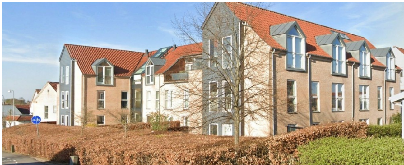
Etageboligbyggeri Bays Have i Asnæs
