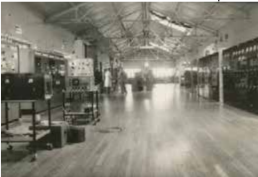
Ca. 1939: Foto fra sendersalen i den oprindelige bygning. Ovenlys er tilføjet.
