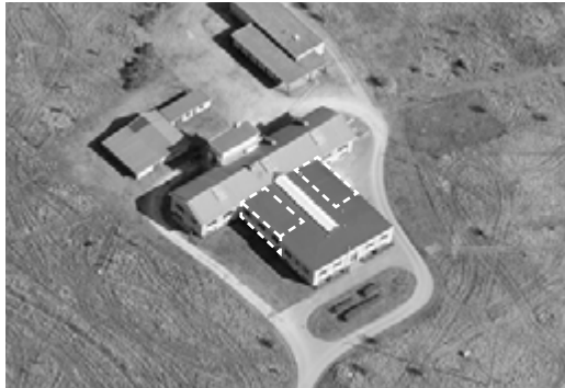
Ca. 1965-1968: Sidste store tilbygning af hovedbygningen. Den lille sendesal udvides mod øst og vest med laboratorium, undervisningslokale og kontorer.
