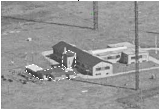
Uden præcist årtal: Antennetårnet og materielbygning blev opført.
