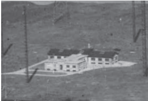
Uden præcist årtal: Ny tagbeklædning med tagpap på den oprindelige bygning. Måske endnu tidligere i forbindelse med isætning af ovenlys.
