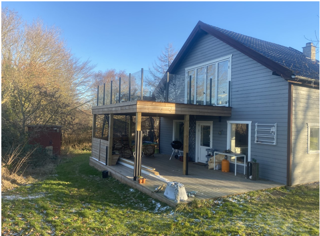
Foto af opført overdækket terrasse og åben tagterrasse.
