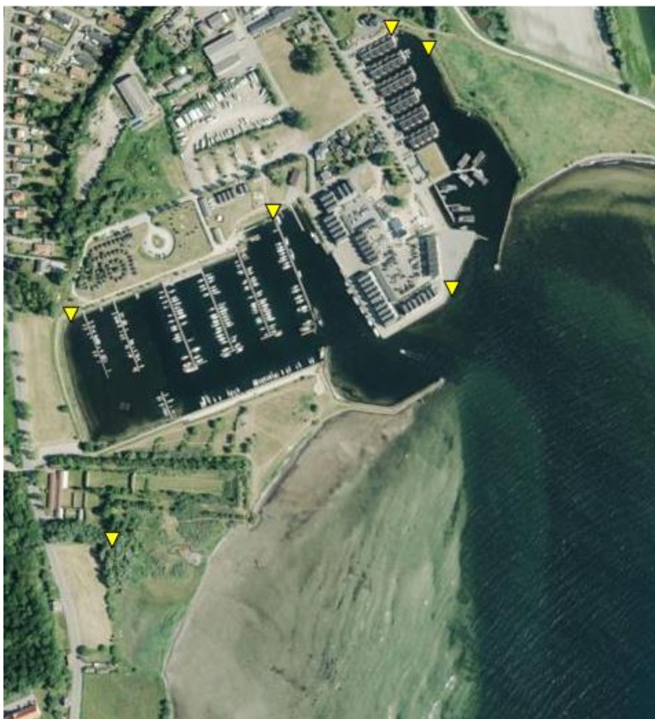
Figur 3.19 Eksisterende udløb fra kloaksystemerne
