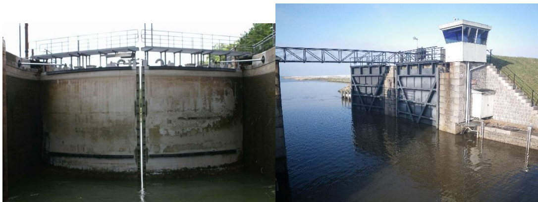
Figur 5.3: Eksempler på Sluser/Højvandssikringer. Til venstre en sluseport fra Göta Älv i Sverige, Foto: Rejseavisen.dk . Til højre er Kammerslusen i Ribe, Foto: Helle Otzen
