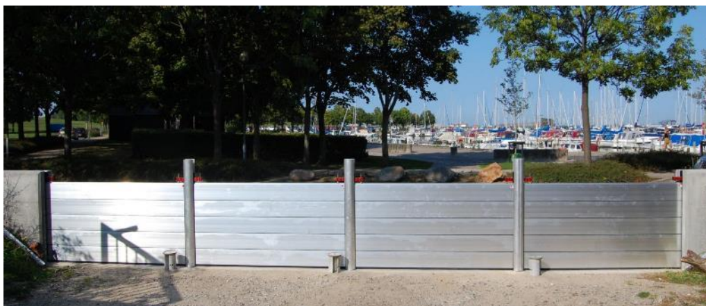
Figur 3.11: Eksempel på flytbar sikring [Foto fra husportalen.eu].
