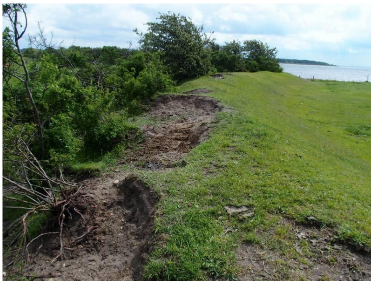
Figur 3.1: Ringholmdiget øst for Ringholm, hvor der opstod digebrud.
