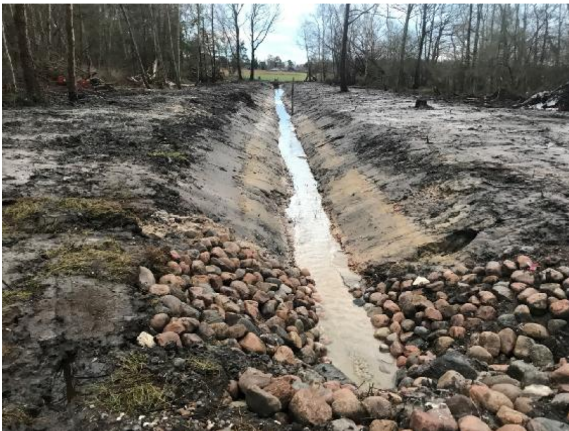
Figur 3 Den nye grøft på matr.nr. 18ch Yderby By, Odden
