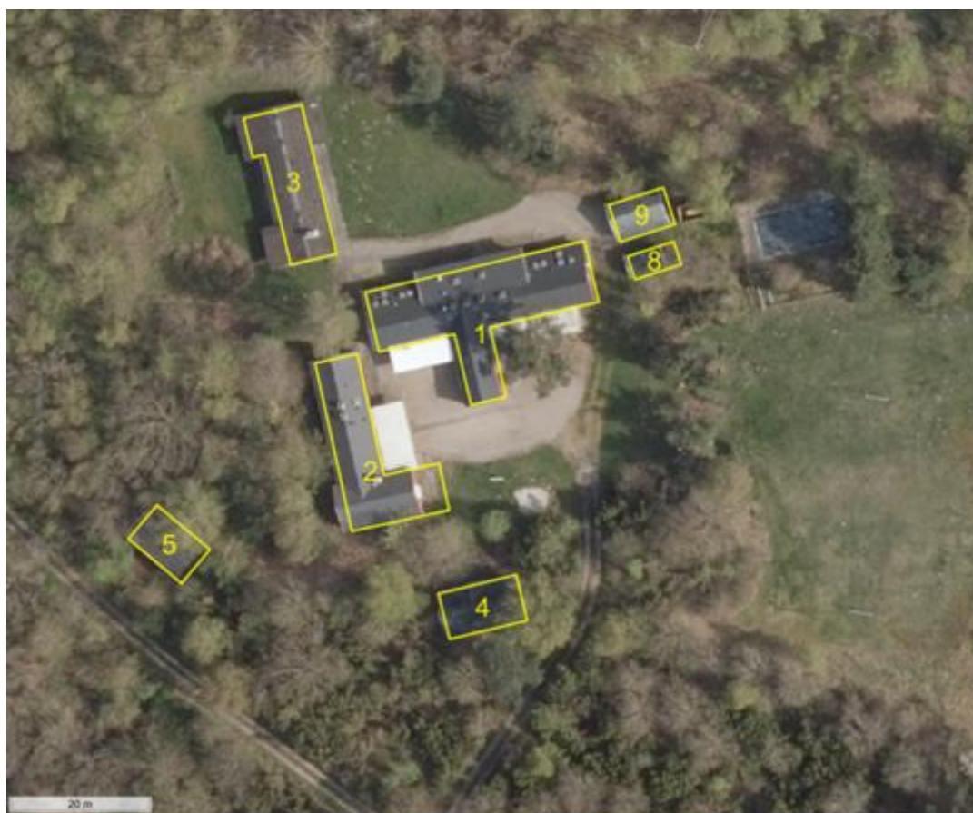
Figur 17. Luftfoto fra 2016 med angivelse af nummer af ejendommens bygninger fra BBR. Gul streg angiver bygningernes nuværende udstrækning.
