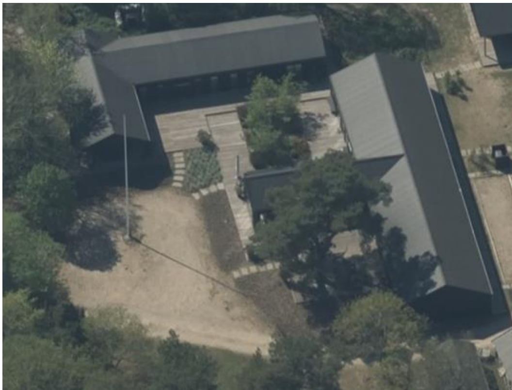
Figur 24. Skråfoto fra 2023 set fra øst af det terrænregulerede område mellem bygning 1 og 2, hvor der er etableret terrasse og haveanlæg.
