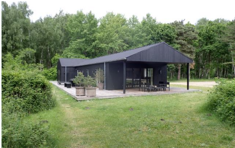
Figur 20. Bygning nr. 3 set fra syd.
