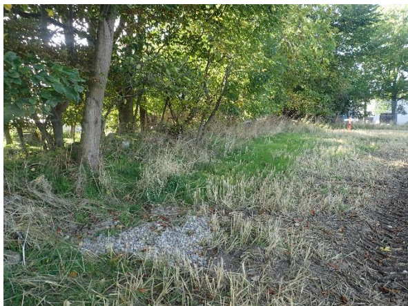
Figur 5: Diget set fra nord.
