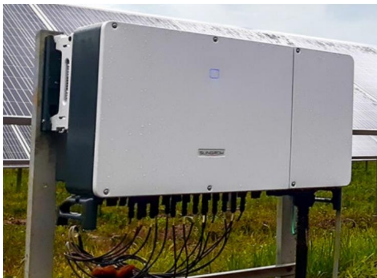
Figur 9. Eksempel på Inverter, som omdanner den producerede jævnstrøm til 230 V vekselstrøm (fra miljøvurderingen).
