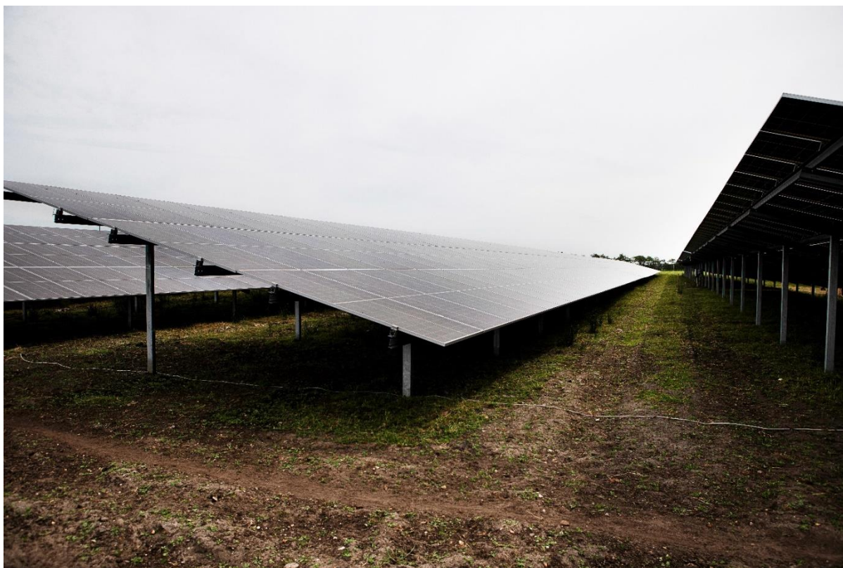
Figur 8. Eksempel på solcellerække med fastmonterede solcelleborde (fra ansøgningen).
