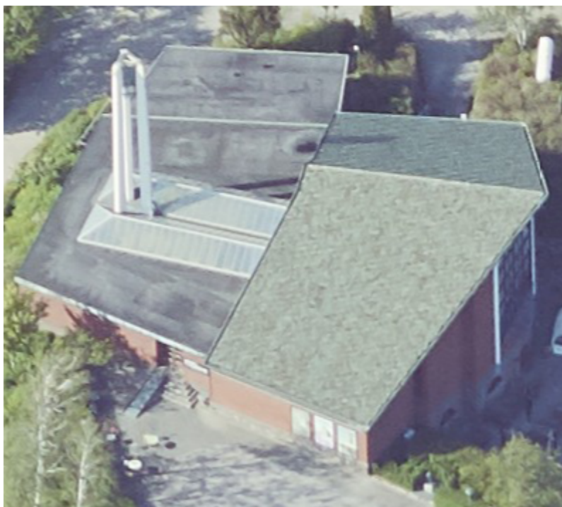
Figur 3 Skråfoto af eksisterende museumsbygninger - det flade tag til venstre ønskes ændret til saddeltag
