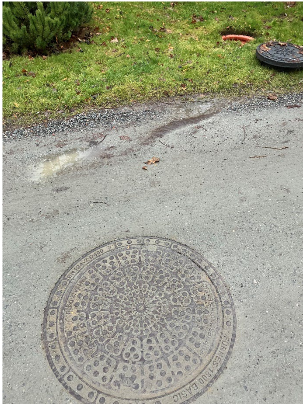
Figur 5 - Brønd i Næsgårdsvej. I baggrunden ses sandfangsbrønden på Gl. Næsgårdsvej 2.
