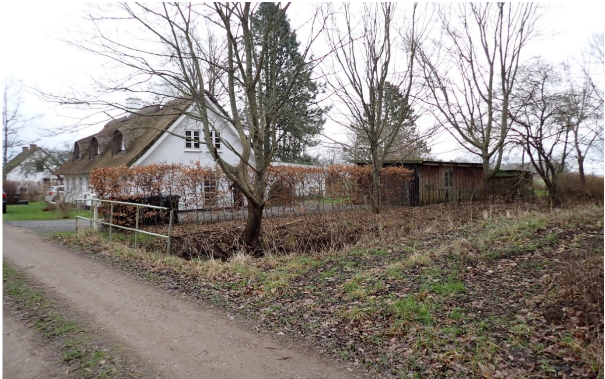
Figur 14. Garage og brændeskur/tørrehus set fra nordvest 16. januar 2025.
