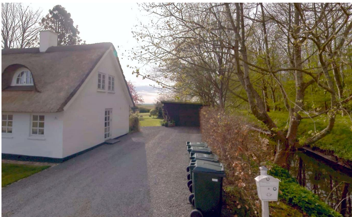
Figur 15. Garage set fra nord, COWI gadefoto 30. april 2024.
