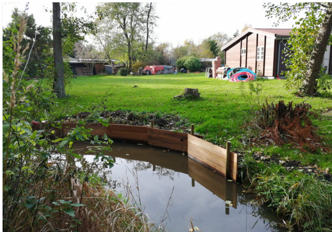
Figur 3. Foto fra 3. november 2022 af palisade placeret ud for Møststien 8.
