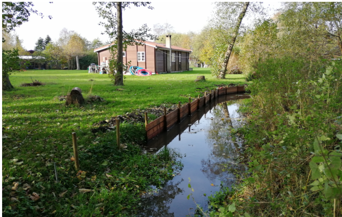
Figur 2. Foto fra 3. november 2022 af palisade placeret ud for Møststien 8.
