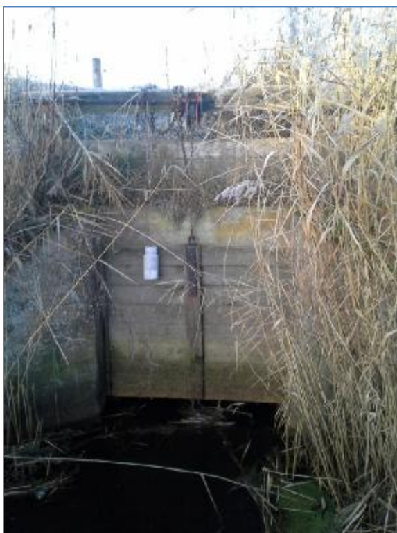
St. 3647 Indløb sluse
