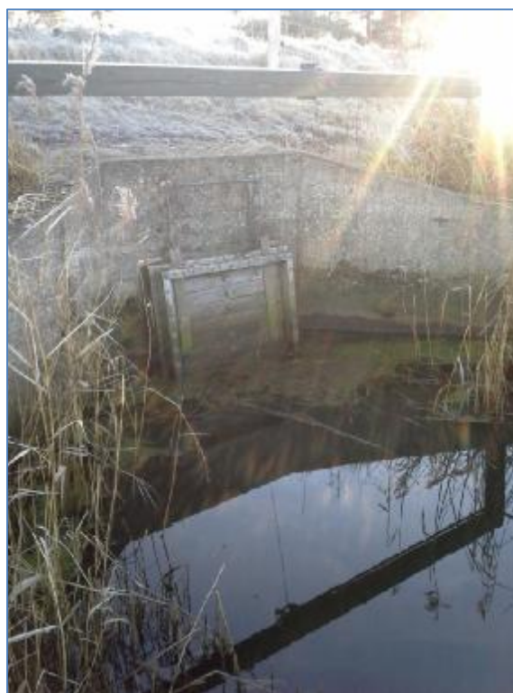
St. 3656 Dige – Sluse udløb
